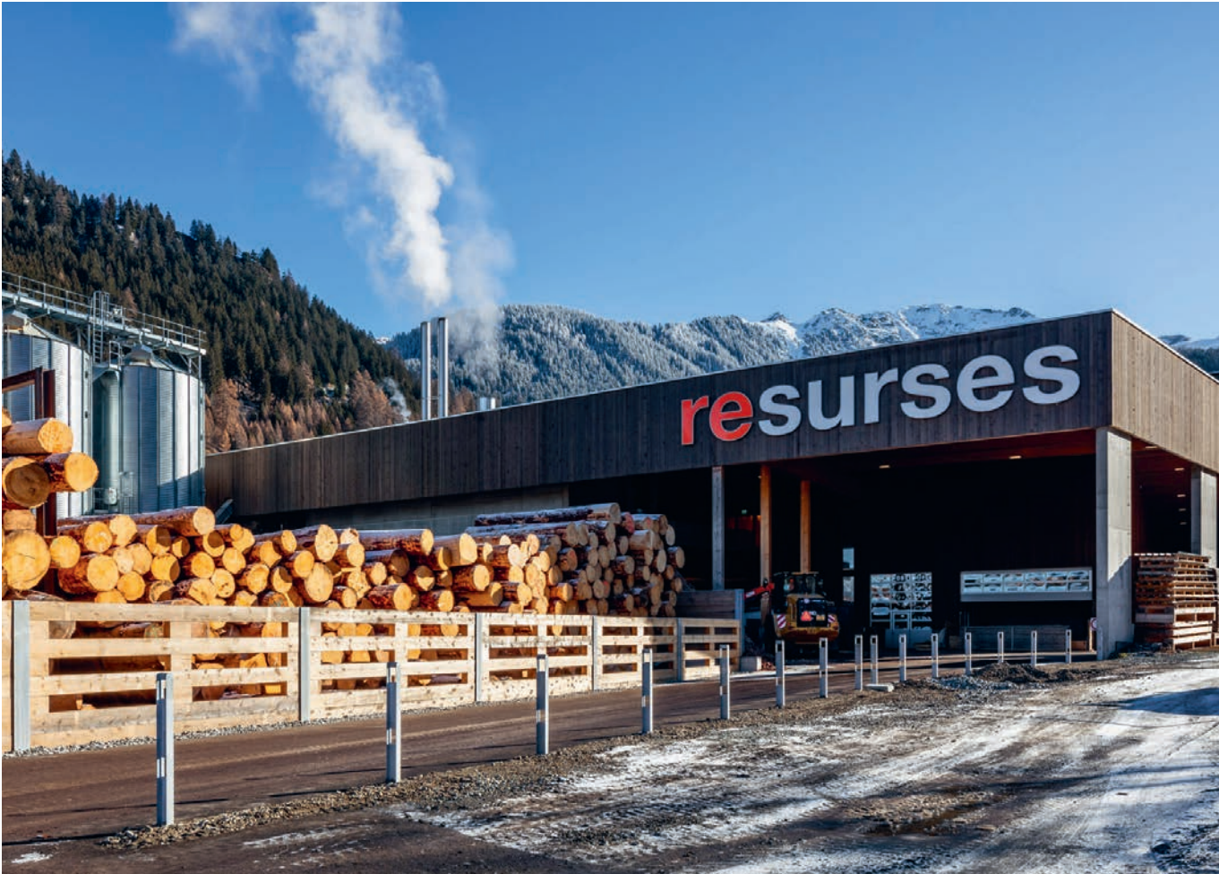
Seit zwei Jahren wird in der Gemeinde Surses wieder Holz verarbeitet. Mit dem automatisierten Sägewerk entstand zeitgleich ein Produktionswerk für Pellets und Pflanzenkohle.
